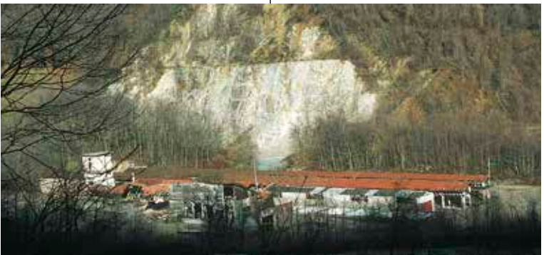
La cava di Caolino e le tettoie di essicamento (circa vent'anni fa)
